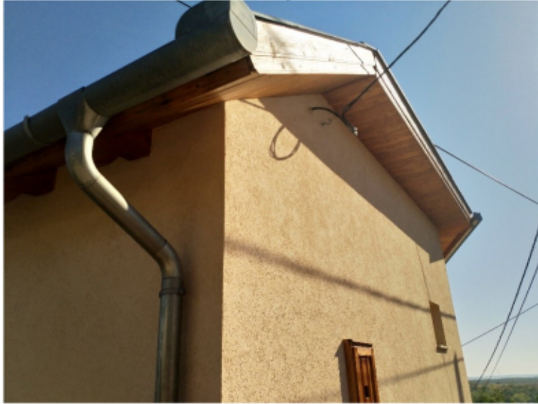
Külső lazúrozás, homlokzat javítás
