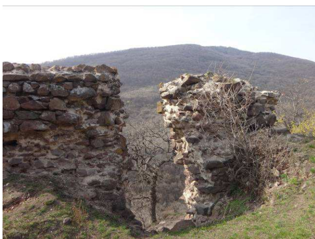
43-44-45. A nyugati fal déli, középső és északi szakaszai belül, keletről
